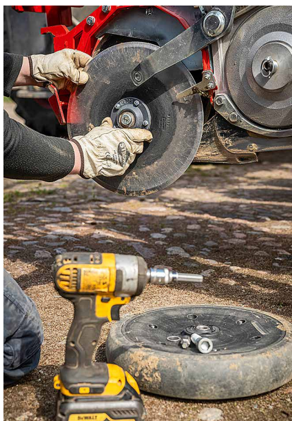
Mit einem Schlagschrauber sind Tasträder und Schneidschneiden schnell demon- tiert.
